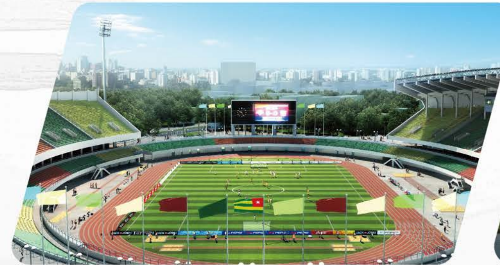
援某国体育场项目 Project Helping Stadium in A Country
